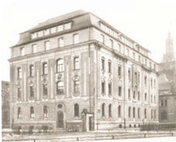
Das Amtsgebäude in der Lerchenfeldstraße 1 wurde 1890/91 eigens für das Statistische Bureau gebaut. Ursprünglich besaß es zwei Stockwerke. 1924 musste es nochmals aufgestockt werden, wie hier zu sehen ist. Im Hintergrund das Bayerische Nationalmuseum.
