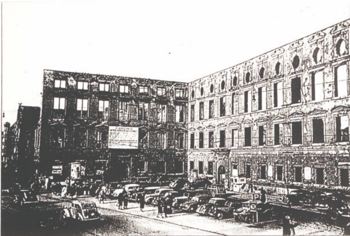
Vom Krieg zerstört: Nach dem Bombenangriff blieb 1944 von der Alten Akademie nur noch die Fassade übrig. Das Äußere wurde sorgfältig restauriert. Das Innenleben wurde im Stil der 50er Jahr neu aufgebaut, wobei sich auch die Stockwerksgliederung verschob.
